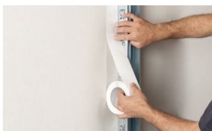
2. Nalepte Trenn-Fix vedle profilu
