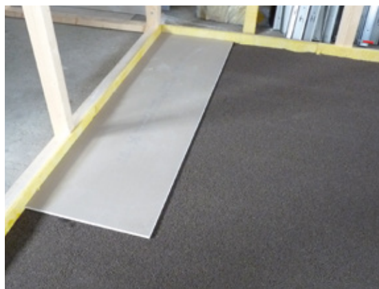
Založení první vrstvy desek
