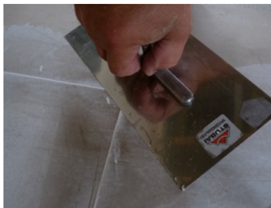
Tmelení spár tmelem Knauf Uniflott
