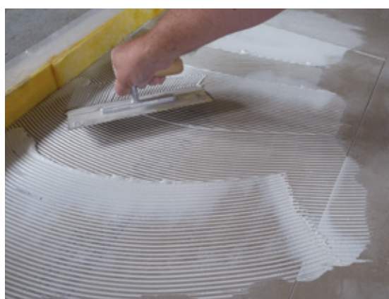
Nanesení lepidla Knauf Fugenfüller
