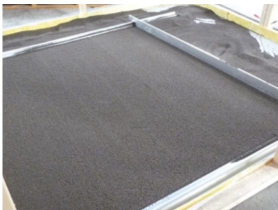
Vyrovnání podkladu suchým podsypem
