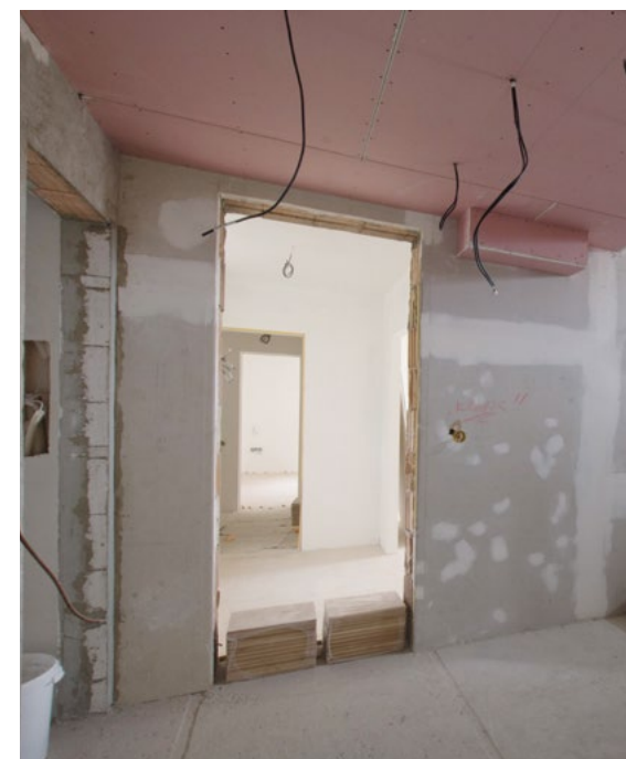
Detail sádrokartonové příčky z akustických desek Knauf Diamant. Příprava na pokládku suché podlahy Knauf BRIO (podsyp).
