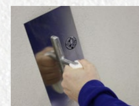
Srovnejte do průměrné tloušťky vrstvy 3-5 mm a zafilcujte do konečné podoby hladítkem.
