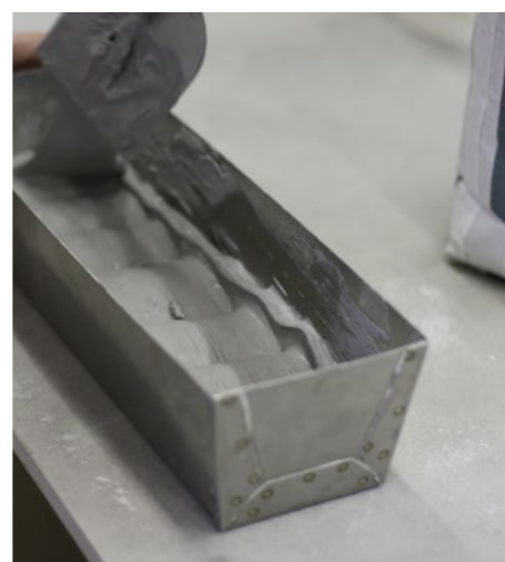
Prášek Drystar-Filler smícháme s vodou na pastózní tmel
