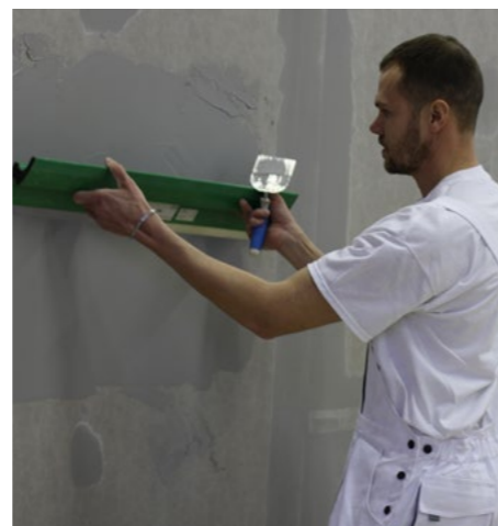
Celoplošné tmelení pod finální úpravu nátěrem nebo malbou
