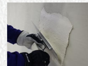
Nanášejte hladítkem rovnoměrně v jedné vrstvě v potřebné tloušťce na podklad.
