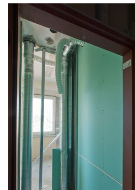
Rekonstrukce sociálního zařízení s využitím „zelené desky“, vhodné do vlhkých prostor
