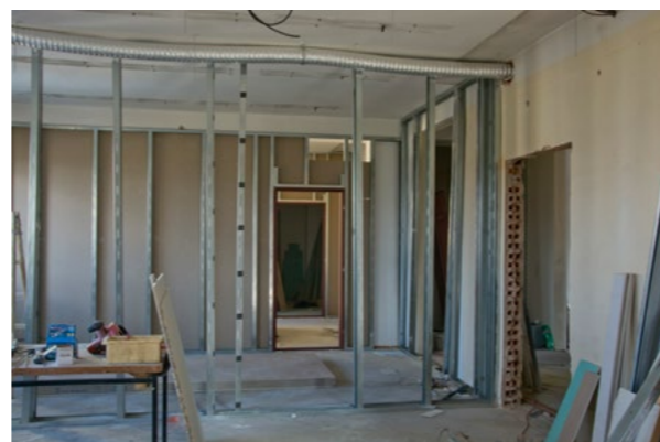
Konstrukce mezibytové příčky-sádrokartonové desky Knauf White s izolací Knauf Insulation
