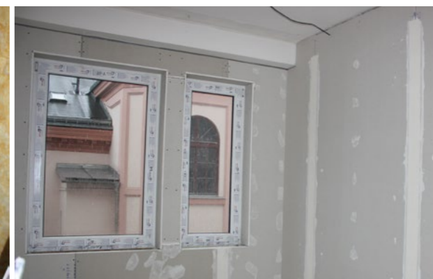
Mezibytová příčka a přesazená stěna (u oken) ze sádrokartonu Knauf
