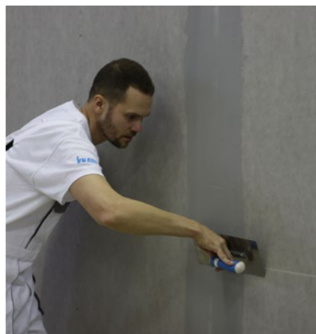
Po vyplnění spáry překryjeme výstužnou páskou Knauf Kurt a přetmelíme systémovým tmelem Drystar-Filler
