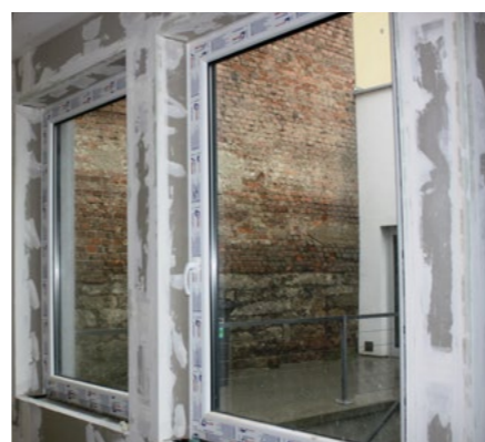
Ostrý profil na vnější roh Sheetrock Dallas vytváří dokonalou a efektní ochranu rohu
