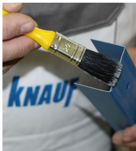
Ošetření řezné hrany opravným lakem
