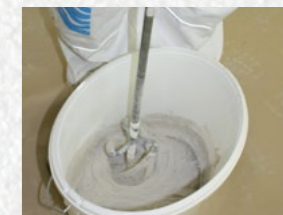
Rozmíchejte směs v čisté vodě, cca 0,25 l vody na 1 kg suché maltové směsi.
