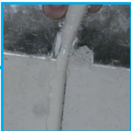
5a. Odstranění přebytečného lepidla špacetlí po 12 hodinách
