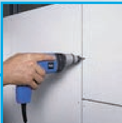
2. Upevňování k podkonstrukci
