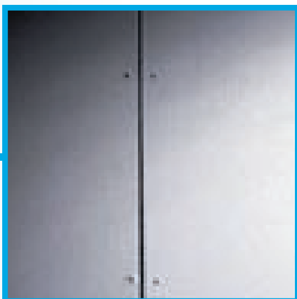
3. Konstrukce připravená k tmelení – šířka spáry 7 mm
