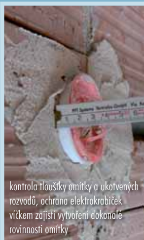
nanášení strojní sádrové omítky
