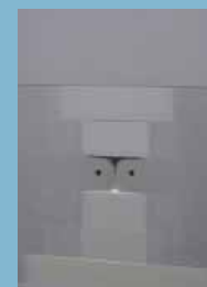
Zatmelená hrana HRAK tmely Knauf, zde v kvalitě Q4
