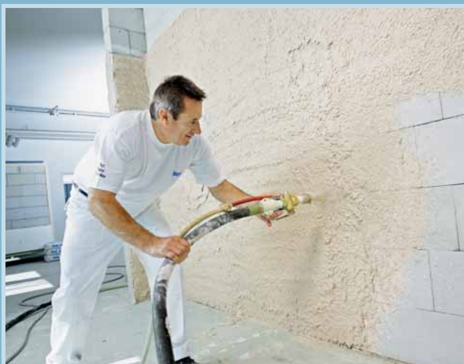
závěrečné uhlazení povrchu sádrové omítky
