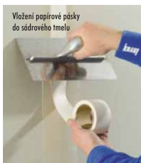
Tmelení hrany HRAK se samolepící páskou (svislá), příčné hrany se skelnou páskou a použití ochrany rohů
