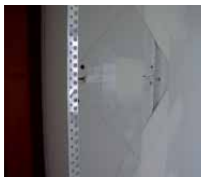
Tmelení hrany HRAK se samolepící páskou (svislá), příčné hrany se skelnou páskou a použití ochrany rohů
