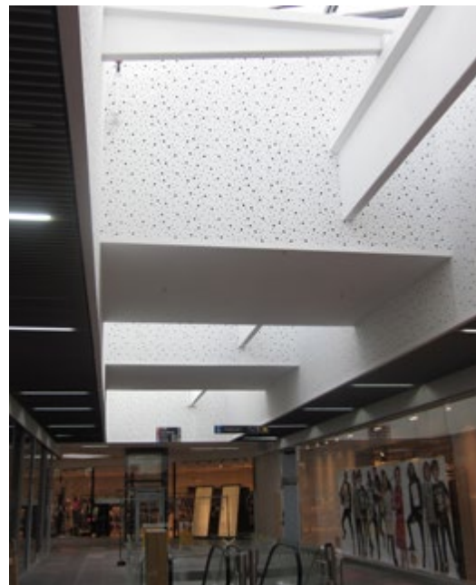
▲ Interiér OC FRÝDA, děrované desky Knauf ▶ Interiér OC FRÝDA, sádrokarton a děrované desky Knauf
