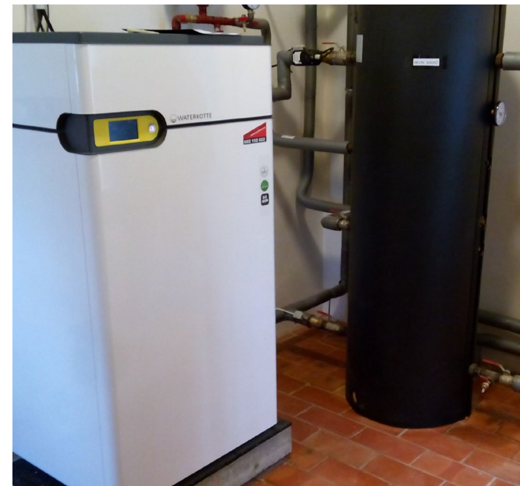
► Instalace tepelných čerpadel na zámku Veltrusy
