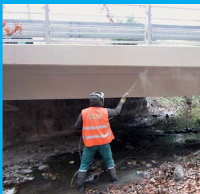
Strojní nanášení ochranného nátěru TS 710
