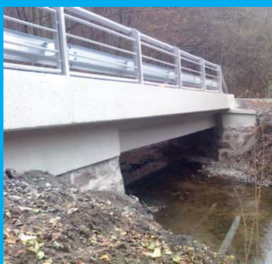
Most po rekonstrukci
