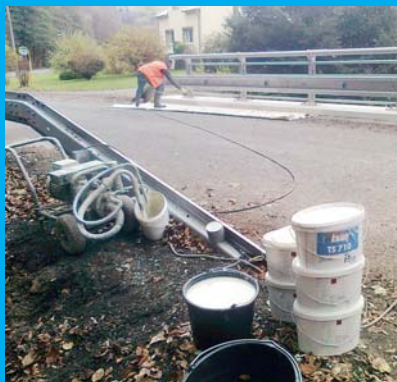
Ruční aplikace penetrace betonu TS 710
