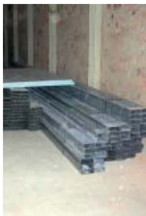
Příprava podhledu po protipožárním nástřiku
