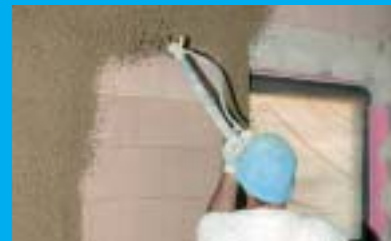
1. Strojní aplikace sádrové omítky
