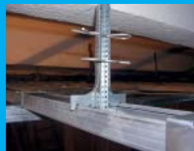
Příprava špalety před montáží Aquapanelu
