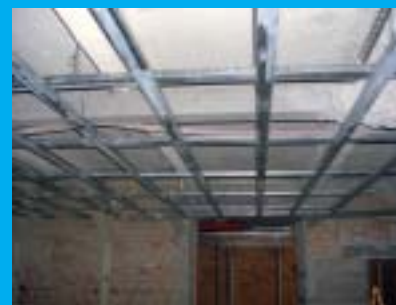
Uchycení CD profilu na závěs Nonius před montáží Aquapanelu
