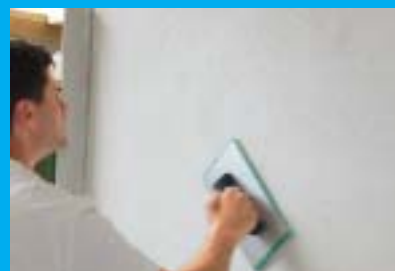
▲ Úprava povrchu Kbelorit Struktural neoprénovým hladítkem
